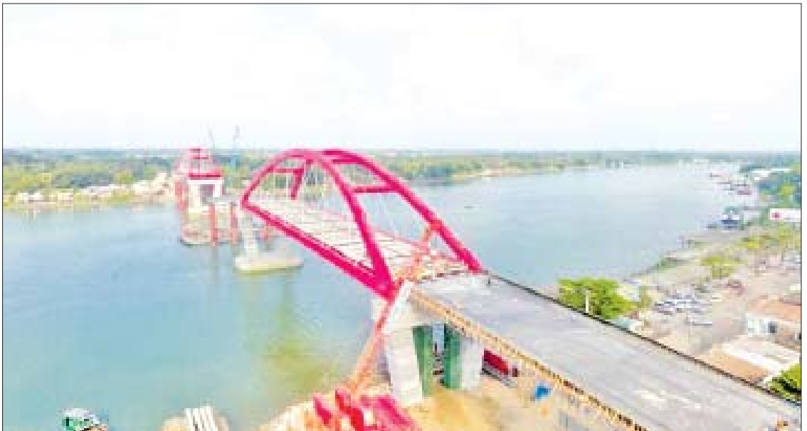
ပုသိမ်တံတားအမှတ် (၂) တည်ဆောက်ရေးစီမံကိန်း၏ တံတားသစ်တည်ဆောက်ပြီးစီးနေမှုအား တွေ့ရစဉ်။
