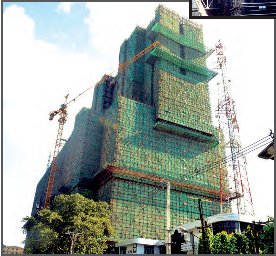
ပြည်ပအင်ဂျင်နီယာများဖြင့် ဆောက်လုပ်နေသော ရန်ကုန်မြို့ပြဖွံ့ဖြိုးမှုအဆောက်အအုံကို တွေ့ရစဉ်။
