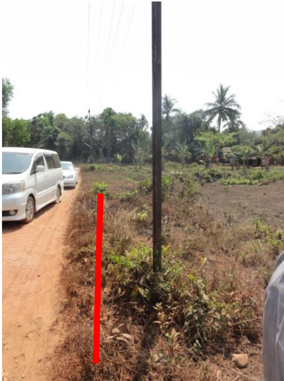
ပုံ ၅-၂၃ ။ ဆောက်လုပ်မည့် ရေပိုက်လိုင်းသည် လက်ရှိလမ်းများနှင့်အပြိုင် တည်ဆောက်ထားပါသည် ။
