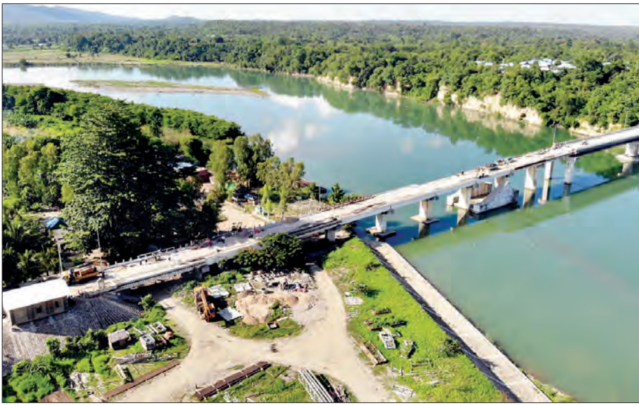
တည်ဆောက်နေဆဲ မဲလီတံတားကို တွေ့ရစဉ်။
