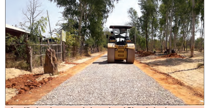
နတ်မောက်မြို့နယ်၊ ကျွမ်းကျင်ကျေးရွာအဝင်လမ်း ကျောက်ချောခင်းခြင်းဆောင်ရွက်နေစဉ်။
