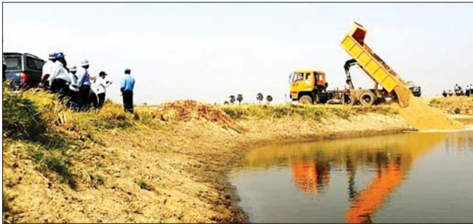
DY-2 ရေပေးမြောင်းကြီး ပြုပြင်မှုကို စက်ယန္တရားများဖြင့် ဆောင်ရွက်နေစဉ်။
