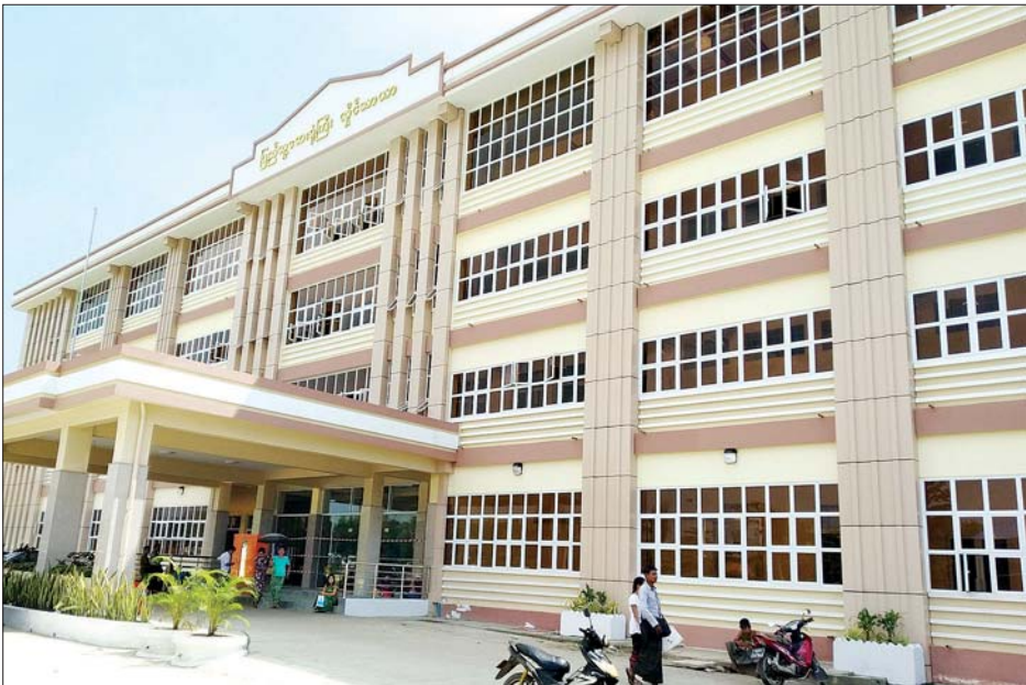
လှိုင်သာယာမြို့နယ်ရှိ တိုးချဲ့လေးထပ်ဆောင်ဆေးရုံကြီးကို တွေ့ရစဉ်။
