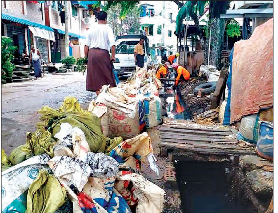
ရပ်ကွက်ရေမြောင်းတစ်ခုတွင် ရေစီးရေလာကောင်းမွန်ရေး အမှိုက်သရိုက်များ တူးဖော်ရှင်းလင်းနေသည်ကို တွေ့ရစဉ်။
