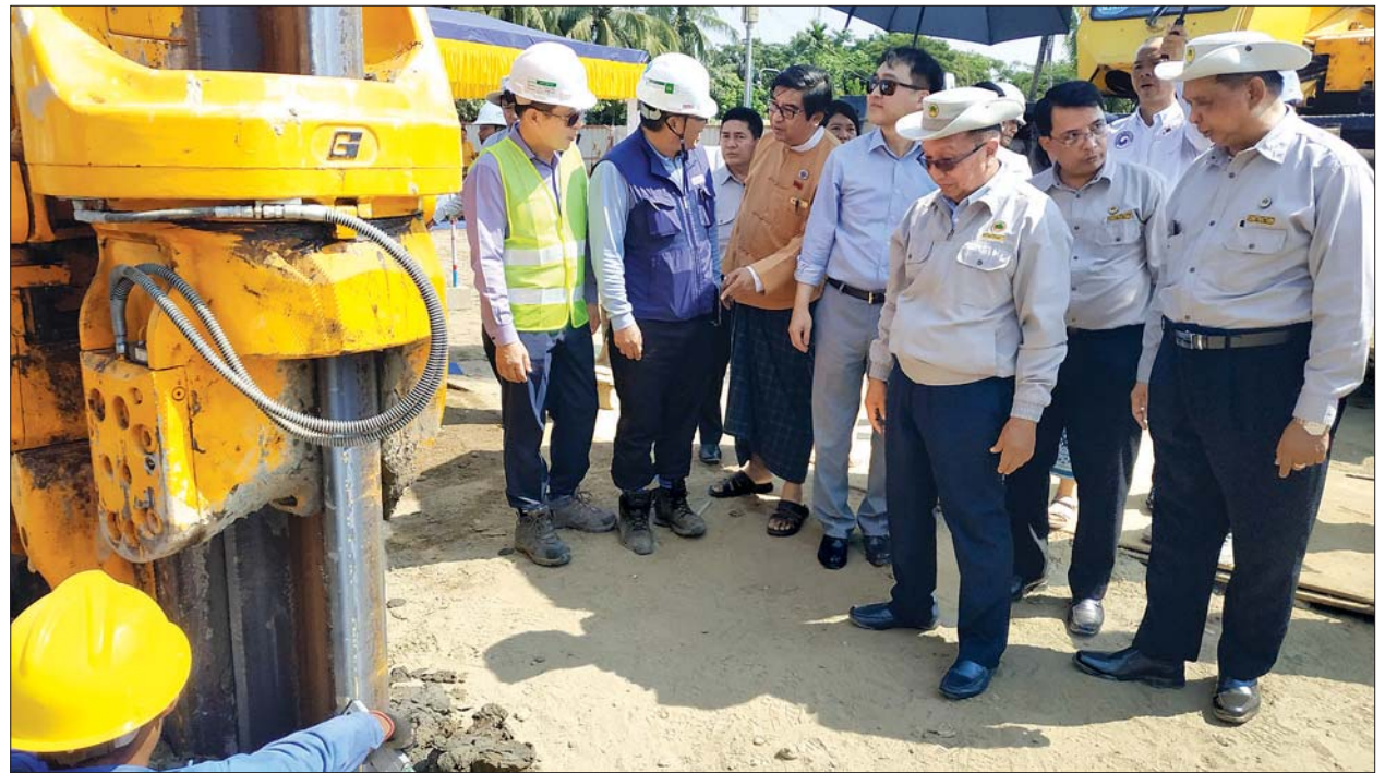
ပြည်ထောင်စုဝန်ကြီး ဦးဟန်ဇော် ကိုရီးယား-မြန်မာချစ်ကြည်ရေးတံတား(ဒလ) တည်ဆောက်ရေးလုပ်ငန်းများ ကြည့်ရှုစစ်ဆေးစဉ်။ သတင်းစဉ်
