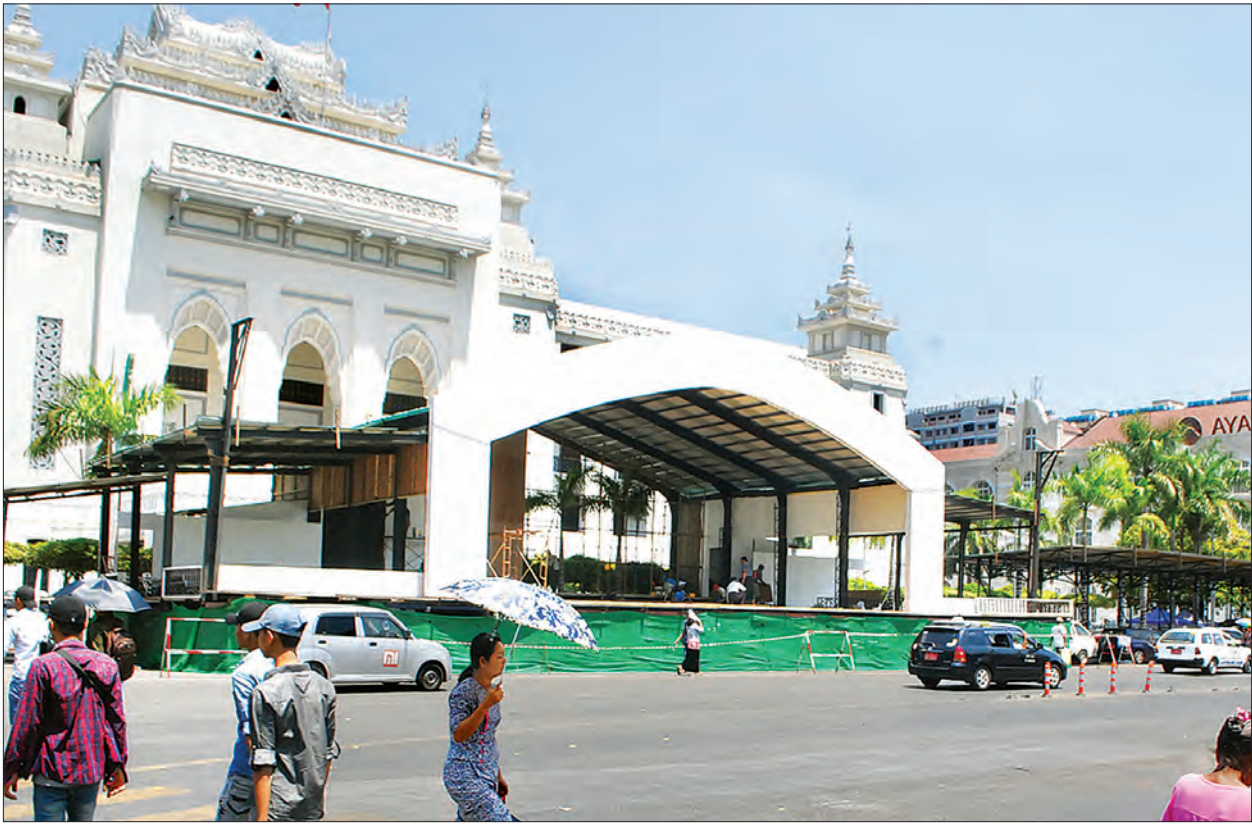
ရန်ကုန်မြို့တော် မဟာသင်္ကြန် ဗဟိုမဏ္ဍပ်တည်ဆောက်နေမှုကို တွေ့ရစဉ်။
