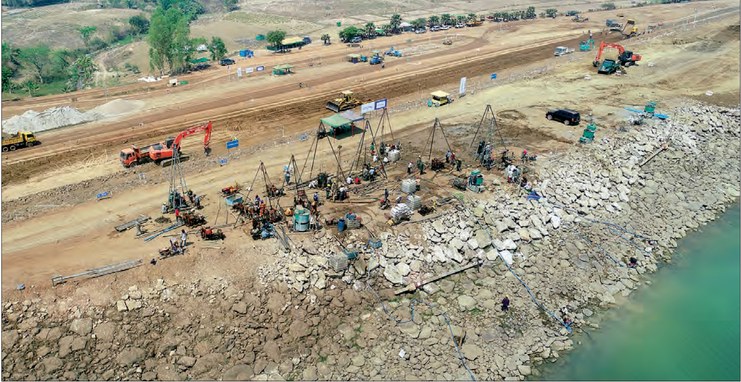
တောင်နဝင်းဆည် တမံထိပ်ပြင် မြေဖို့ခြင်းလုပ်ငန်းကို လူအားစက်အား အသုံးပြု၍ ဆောင်ရွက်နေမှုကို တွေ့ရစဉ်။
