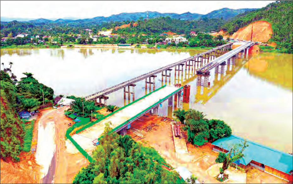
တနင်္သာရီတံတား တည်ဆောက်နေမှုကို တွေ့ရစဉ်။
