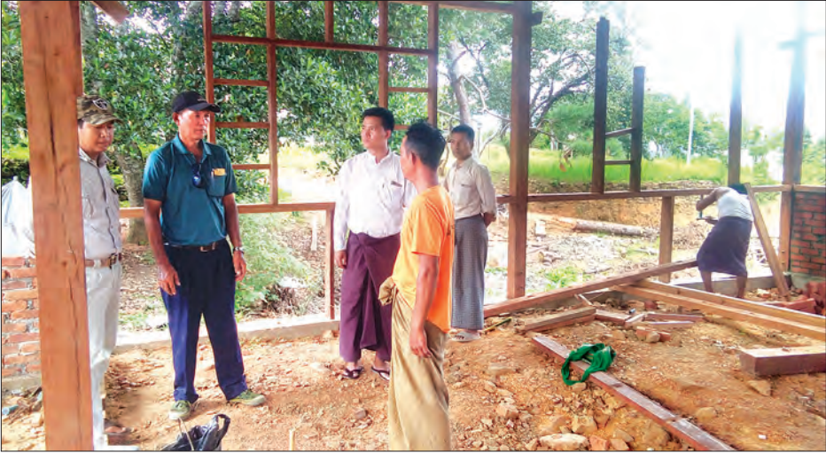
ရိခေါဒါရ်မြို့အခြေခံပညာကျောင်းများတည်ဆောက်ရေး တာဝန်ရှိသူများ ကွင်းဆင်းစစ်ဆေးစဉ်။
