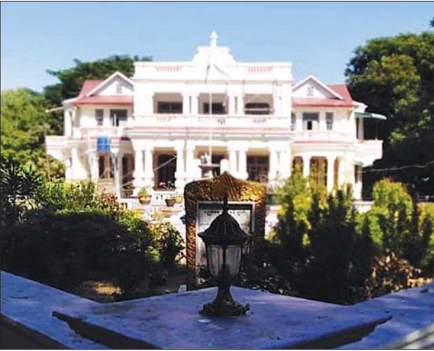
အပြာရောင်ကမ္ဘည်းပြားတပ်ဆင်မည့် အထက (၁) လှိုင်ကျောင်းဝင်းအတွင်းရှိ အဆောက်အအုံ
