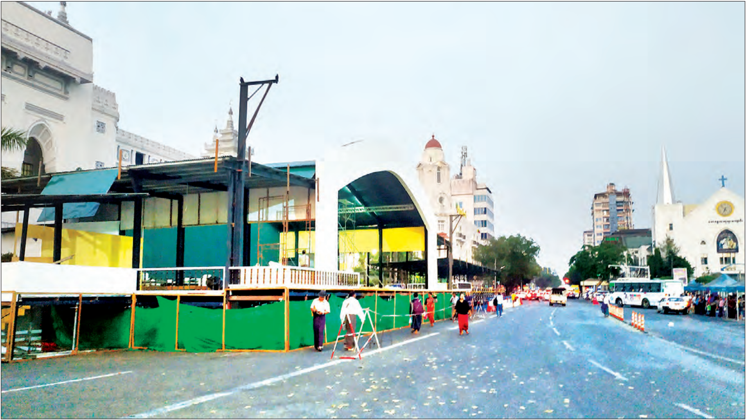
ရန်ကုန်မြို့တော်သူ မြို့တော်သားများအတွက် သင်္ကြန်ကာလပျော်ရွှင်စွာ ဆင်နွှဲနိုင်ရန် မြို့တော်ဝန်မဟာသင်္ကြန်မဏ္ဍပ် ဆောက်လုပ်နေမှုကို တွေ့ရစဉ်။ ဓာတ်ပုံ - အာကာစိုး
