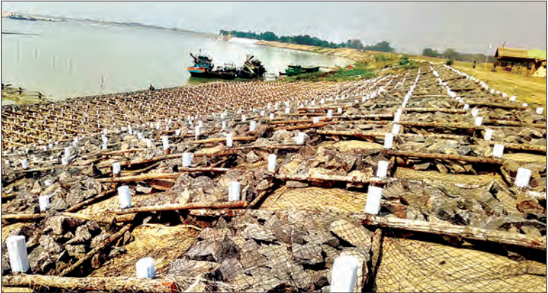
ဗလဗကျေးရွာ ဧရာဝတီမြစ်ကမ်းပြိုကာကွယ်ရေးလုပ်ငန်း ဆောင်ရွက်နေမှုကို တွေ့ရစဉ်။
