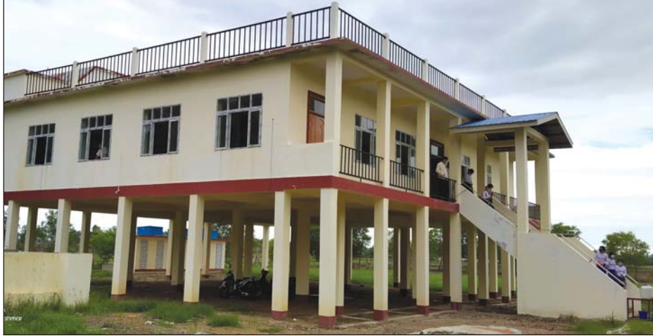
ရာနှုန်းပြည့် ဆောက်လုပ်ပြီးစီးနေသည့် ဘက်စုံသုံးအဆောက်အအုံ။
