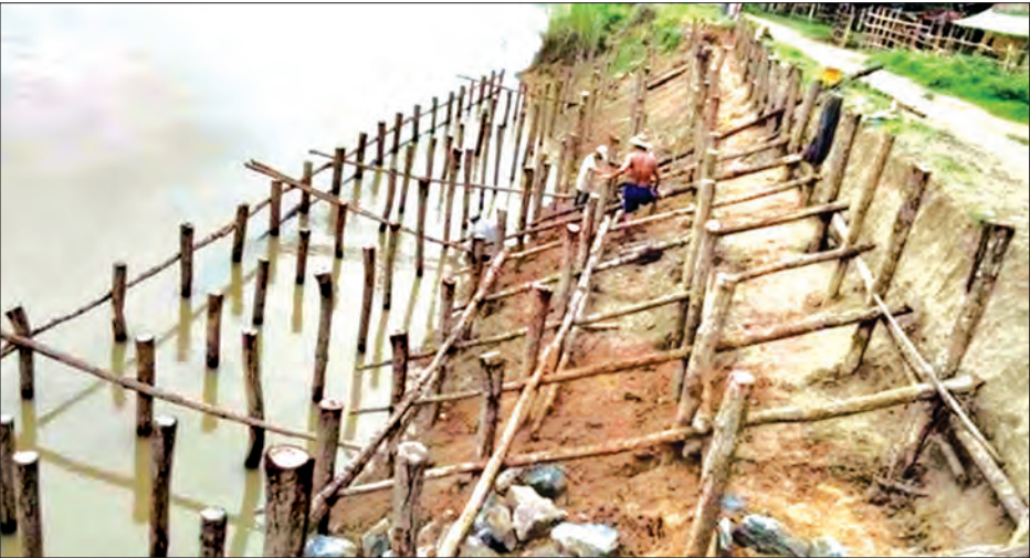
စစ်တောင်းမြစ်ကမ်းပါး မြစ်ရေတိုက်စားမှုမှ ကာကွယ်ရေး တုတ်ရိုက်ရေကာတန်း ဆောင်ရွက်နေစဉ်။
