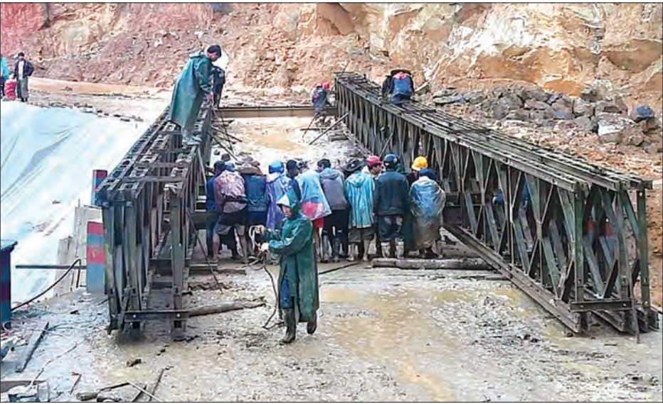
ပျက်စီးသွားသည့် တံတားကို တည်ဆောက်ရေးအဖွဲ့က ပြင်ဆင်မှုများ ဆောင်ရွက်နေစဉ်။
