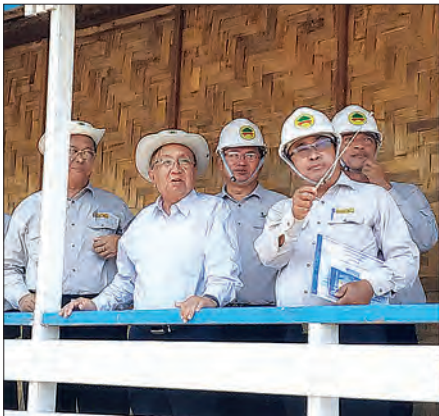
ပြည်ထောင်စုဝန်ကြီး ဦးဟန်ဇော် ကျွဲပွဲ - မြို့ရိုး - ဧရပ်ကြီးလမ်းပေါ်ရှိ စစ်တောင်းမြစ်ကူးတံတား (မြို့ရိုး) တည်ဆောက်ရေးလုပ်ငန်းများအား ကြည့်ရှုစစ်ဆေးစဉ်။
