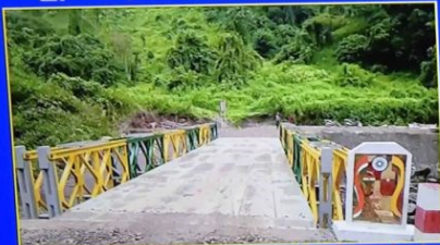
နာဂကိုယ်ပိုင်အုပ်ချုပ်ခွင့်ရဒေသ၊ လဟယ်မြို့နယ်၊ လောင်ကျွန်း နောက်ကျွန်းကျေးရွာတွင် ၆၀ ဖေဘေလီတံတားတည်ဆောက်ခြင်း
