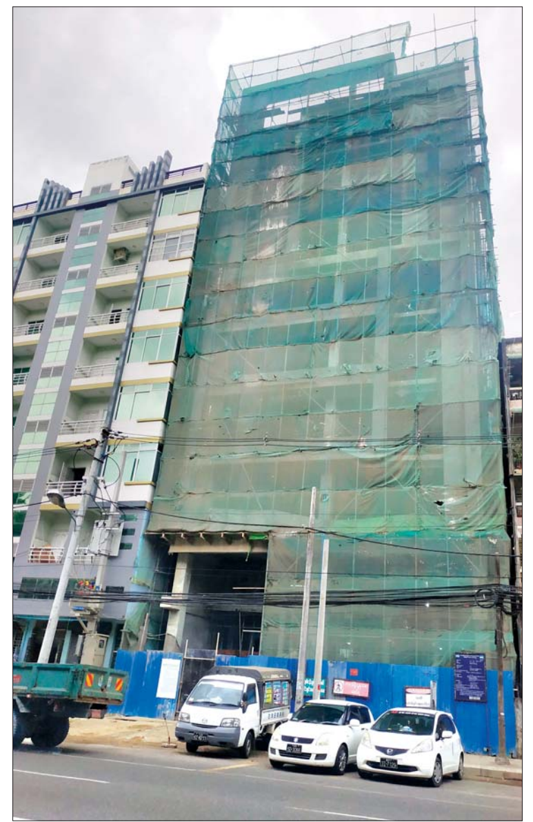
ရန်ကုန်မြို့တွင်း ဆောက်လုပ်ရေးလုပ်ငန်းခွင်တစ်ခုကို တွေ့ရစဉ်။
