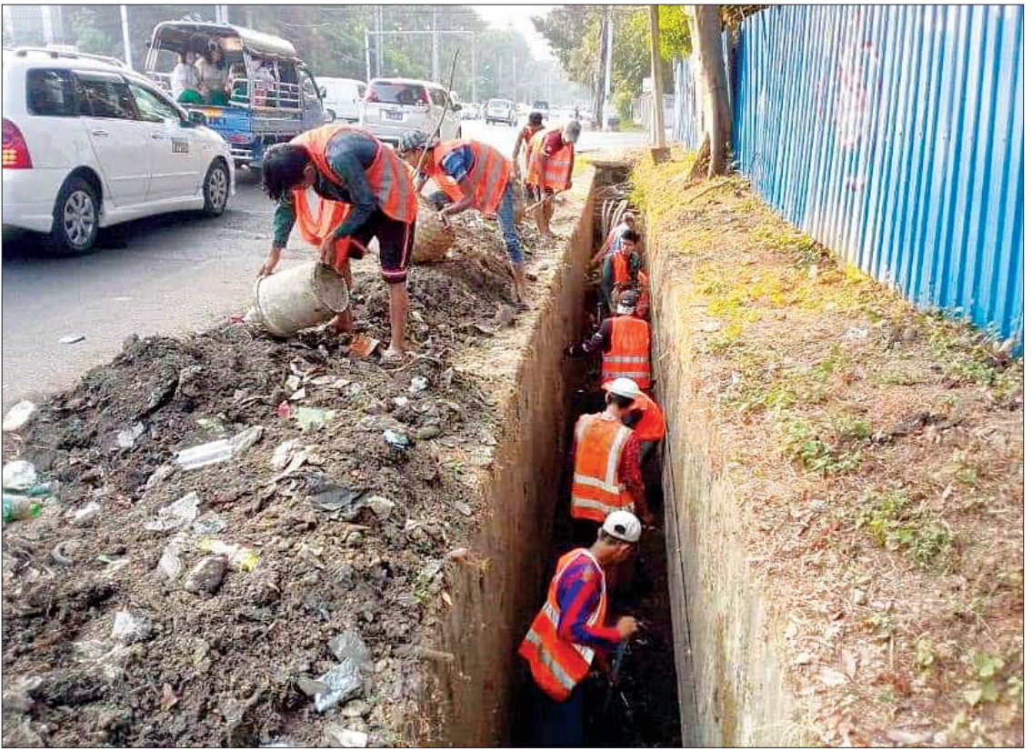
ရန်ကုန်မြို့တွင်းရှိ ရေမြောင်းများ ရေစီးရေလာကောင်းမွန်ရေးအတွက် စည်ပင်ဝန်ထမ်းများက အမှိုက်များ ဆယ်ယူနေမှုကို တွေ့ရစဉ်။
