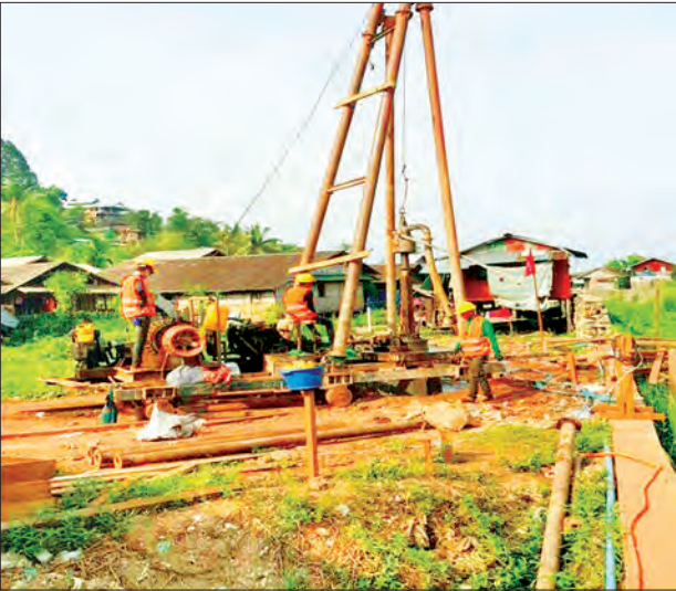
သံကူကွန်ကရစ်တံတားတည်ဆောက်ရေးလုပ်ငန်းခွင်ကို တွေ့ရစဉ်။
