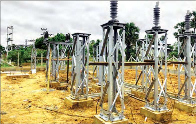
ဓာတ်အားခွဲရုံ တည်ဆောက်ရေးလုပ်ငန်းခွင်ကို တွေ့ရစဉ်။
