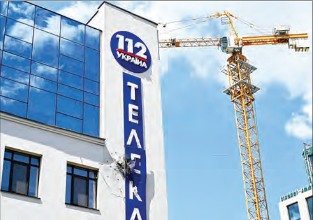
ဒုံးကျည်ဖြင့် တိုက်ခိုက်ခံရသည့် ရုပ်မြင်သံကြားဌာန အဆောက်အအုံ။
