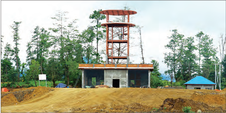
ဖလမ်း (ဆူရ်ဘုန်) လေဆိပ်သစ် လေကြောင်းထိန်းချုပ်စင်တည်ဆောက်နေမှုကို တွေ့ရစဉ်။
