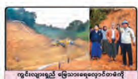
ကွင်းလျားရည် မြေသားရေလျှောင့်တစ်ကို တည်ဆောက်ခြင်း
