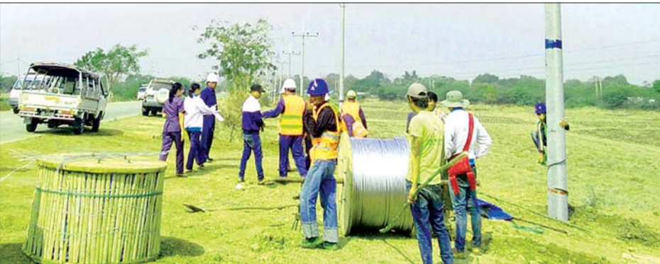
ကျေးရွာများ မီးလင်းရေးအတွက် သက်ဆိုင်ရာတာဝန်ရှိသူများ ဆောင်ရွက်နေကြစဉ်။
