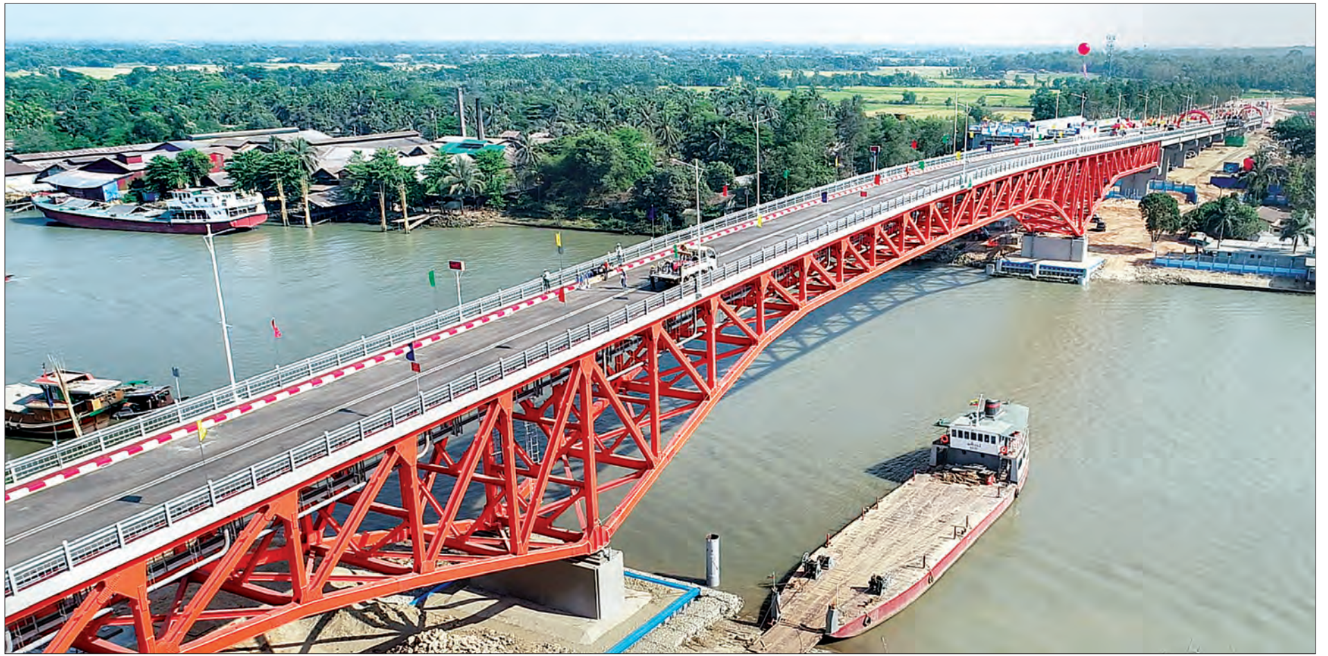
၁-၄-၂၀၁၉ ရက်က ဖွင့်လှစ်ခဲ့သည့် ရွှေမြစ်ကိုဖြတ်၍ တည်ဆောက်ထားသော သံကူကွန်ကရစ်အမျိုးအစား မြောင်းမြတံတားသစ်ကို တွေ့ရစဉ်။
