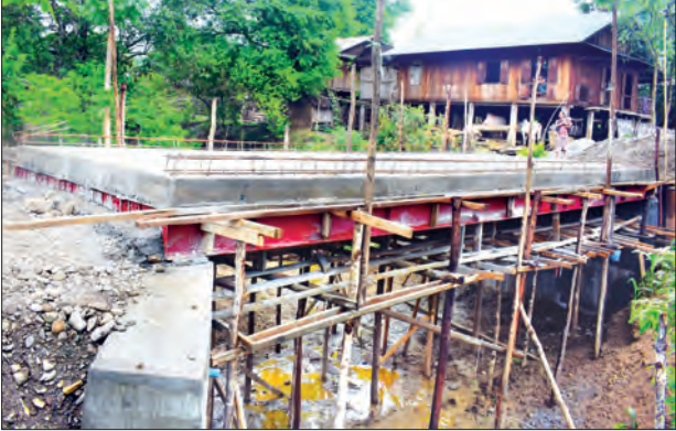
ဆောမြို့နယ် နော်ကျေးရွာရှိ ကွန်ကရစ်တံတား တည်ဆောက်ပြီးစီးမှုကို တွေ့ရစဉ်။
