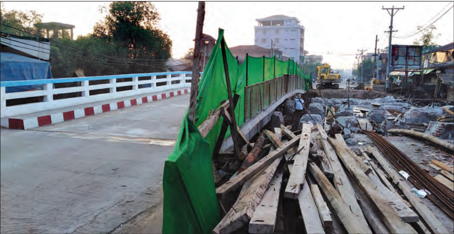
မြိတ်မြို့အဝင် တည်ဆောက်လျက်ရှိသော တံတားတစ်စင်းကို တွေ့ရစဉ်။
