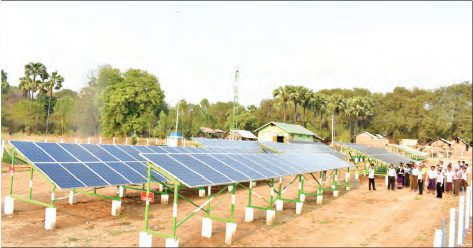
ရေနံချောင်းမြို့နယ်အတွင်းရှိ ကျေးရွာတစ်ရွာတွင် ဆိုလာစနစ်ဖြင့် မီးလင်းရေးလုပ်ငန်း ဆောင်ရွက်ထားစဉ်။
