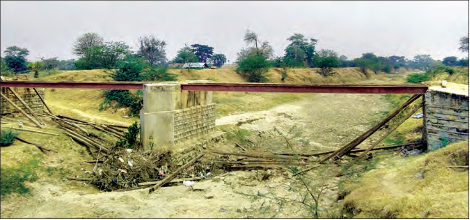
မုန်တိုင်းချောင်းဖြတ် နတ်စင်တံတား ပြန်လည်တည်ဆောက်နေမှုကို တွေ့ရစဉ်။
